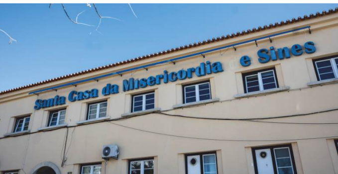
Santa Casa da Misericórdia
