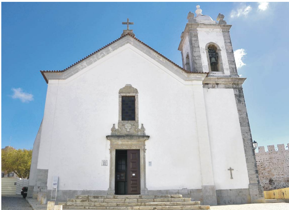
Fig. 5 Fachada da igreja matriz. Sobre a porta, gravada a cruz de Santiago.
