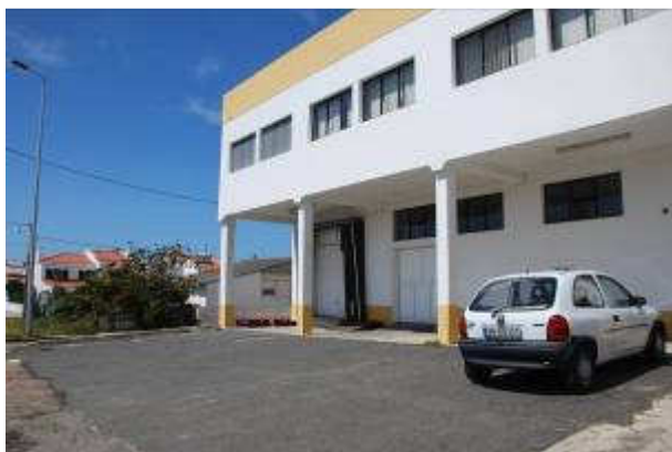
FOTOGRAFIA 1: VISTA PARA O EDIFICADO DE USO MISTO.
