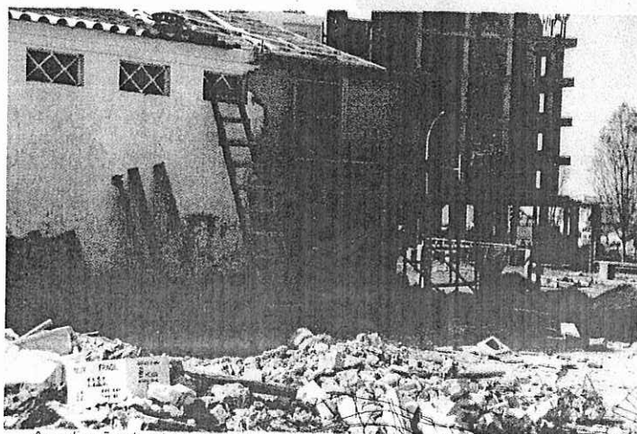
Ampliação das instalações sanitárias da escola nº1 do Ensino Básico
