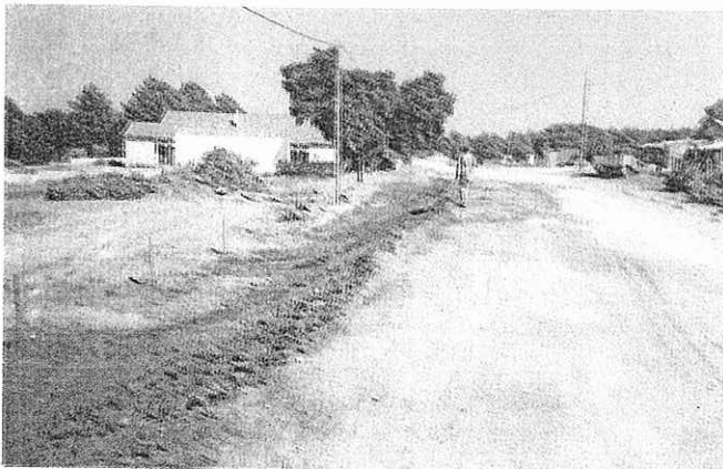
Início das obras de asfalto da estrada do Casoto
