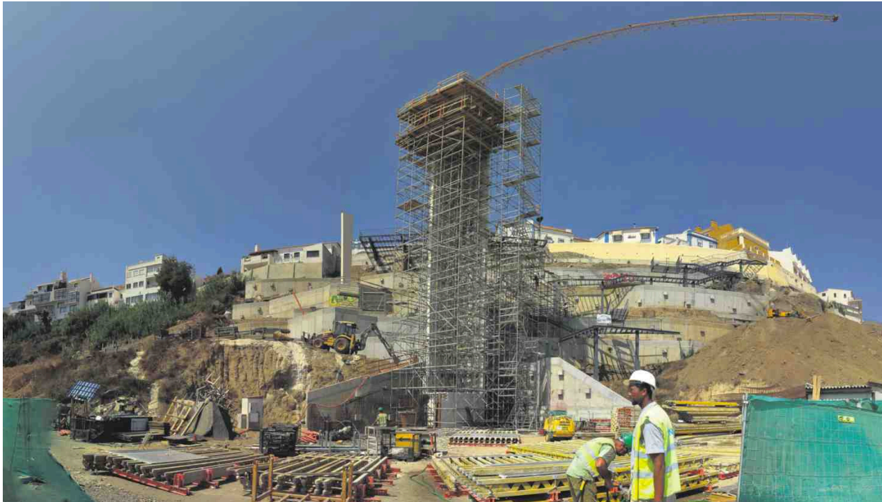
Obra do elevador e contenção da falésia em meados de agosto
