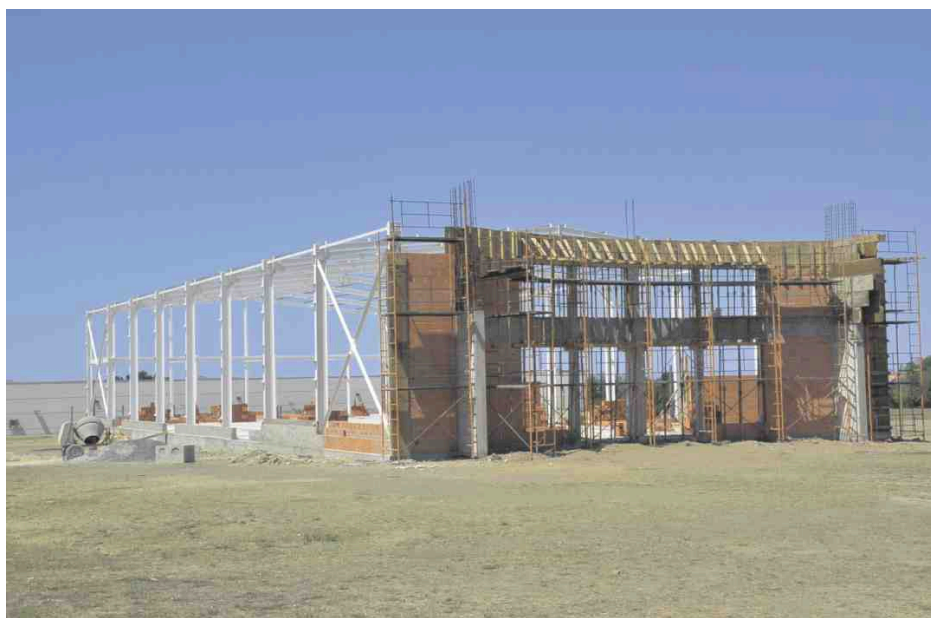
Obra do pavilhão da Junta em meados de agosto
