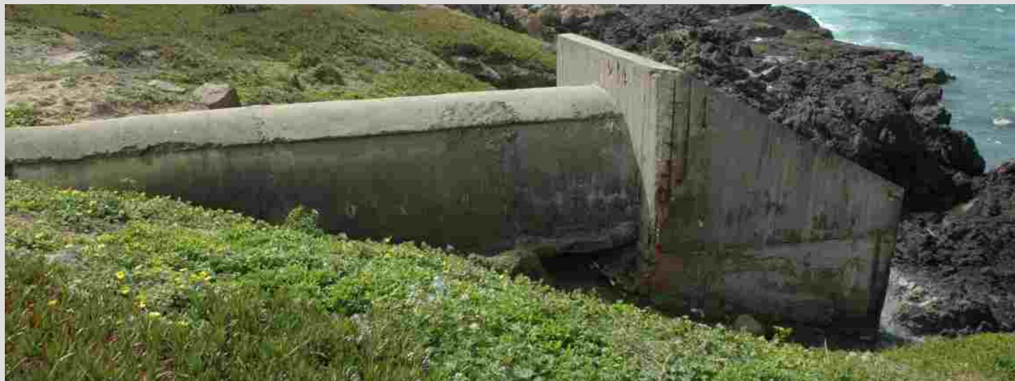
Saída de efluente que vai ser desactivada
