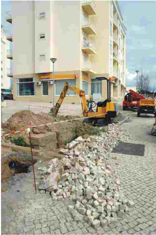
Colocação de troço de conduta
