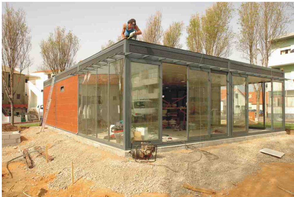
Estado da obra em meados de Março
