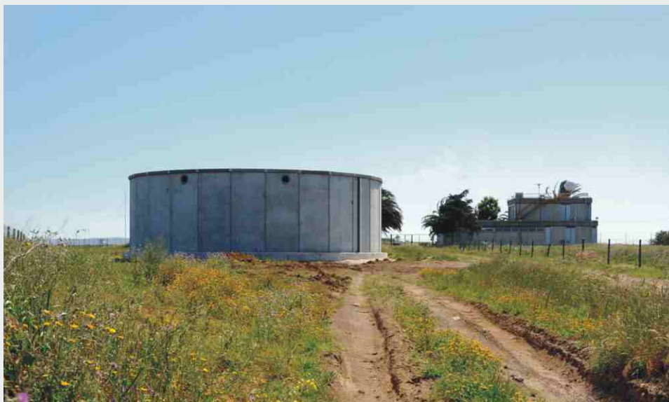
Depósito de água no Monte Chãos
