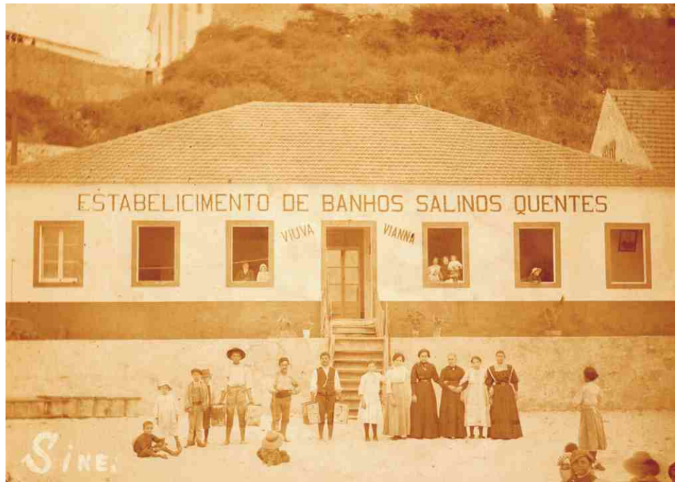
Os Banhos Quentes ficavam encostados à barroca (cerca de 1900)
