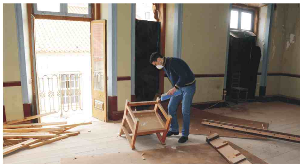
Trabalhos no Centro Recreativo Sineense
