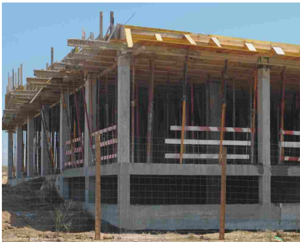
O lar encontra-se em construção desde 2009
