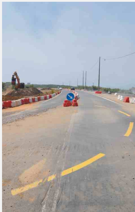
Obra na rotunda de acesso à Cova do Lago
