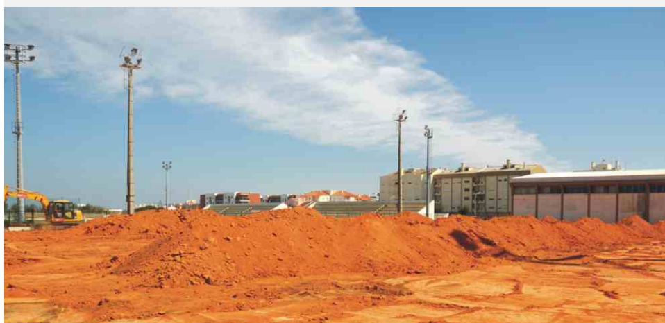
Movimentações de terras para instalação do relvado sintético
