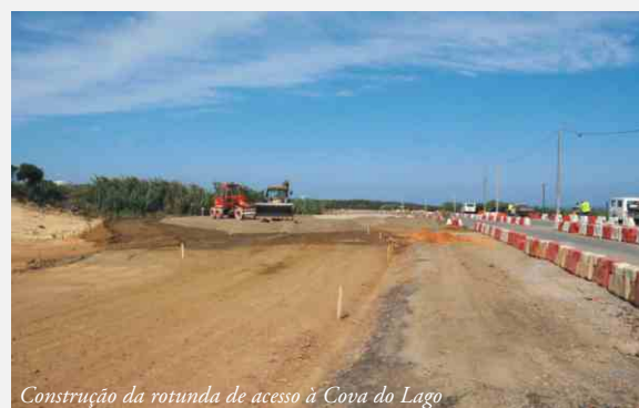
Construção da rotunda de acesso à Cova do Lago
