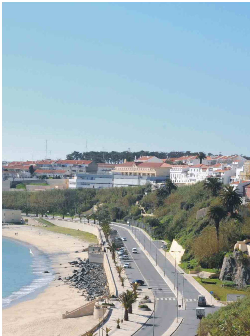
A qualificação da Av. Vasco da Gama, a consolidação da falésia e a construção do elevador entre a Avenida e o Centro Histórico (junto ao Largo dos Penedos da Índia) é a principal obra do Programa de Regeneração Urbana
