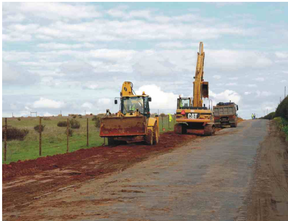
Obras na Estrada Municipal 554 - Porto Covo
