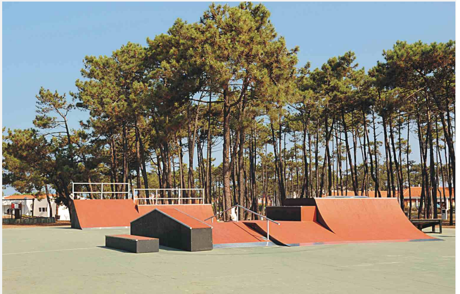
O Skate Parque de Sines foi desenhado com a colaboração dos melhores atletas nacionais da modalidade
