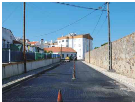
Repavimentação das ruas danificadas: Rua de S. Sebastião
