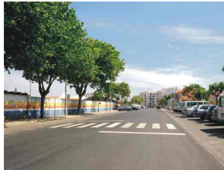
Repavimentação das ruas danificadas: R. Reforma Agrária
