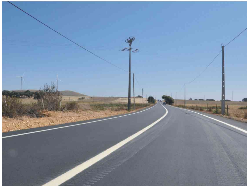
Nova Estrada Municipal 554, com estruturas reforçadas e perfil transversal de 8 metros
