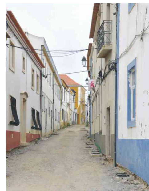
No início do Outono é concluída a pavimentação dos arruamentos com as infra-estruturas já tratadas
