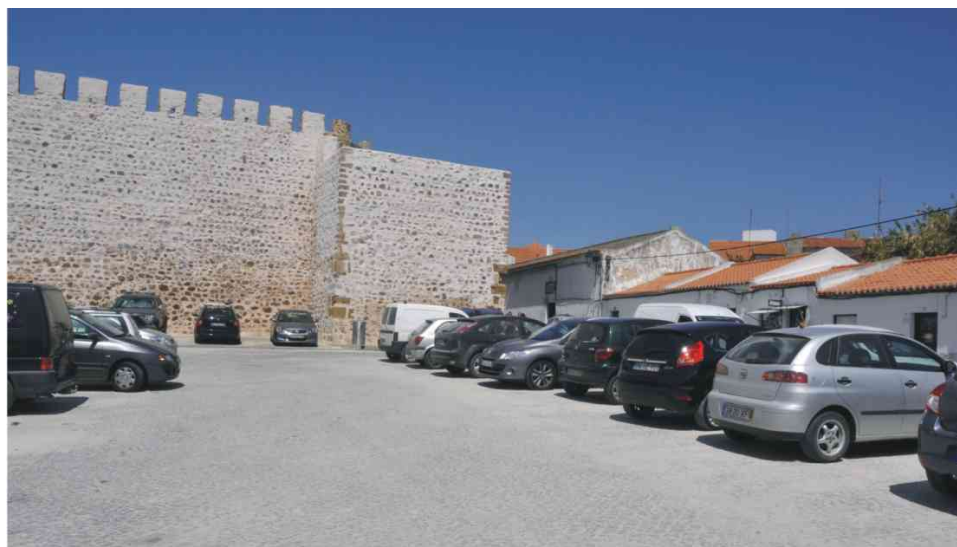
A requalificação do Largo João de Deus, integrada na operação dos espaços pedonais, já permite estacionamento automóvel
