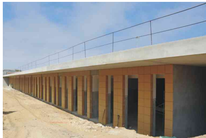
Obra da nova escola básica e pré-escola junto à EB 2,3 Vasco da Gama
