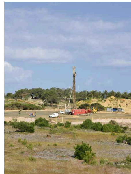
Início das obras
