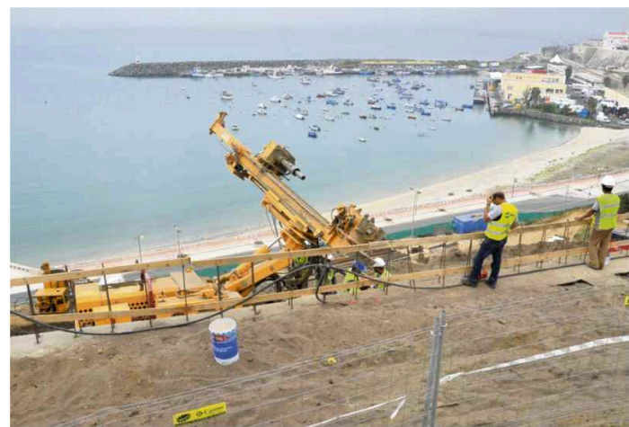
Obras na falésia
