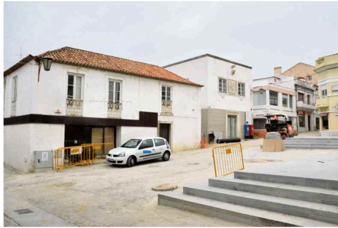
Praça Tomás Ribeiro (operação Arruamentos)
