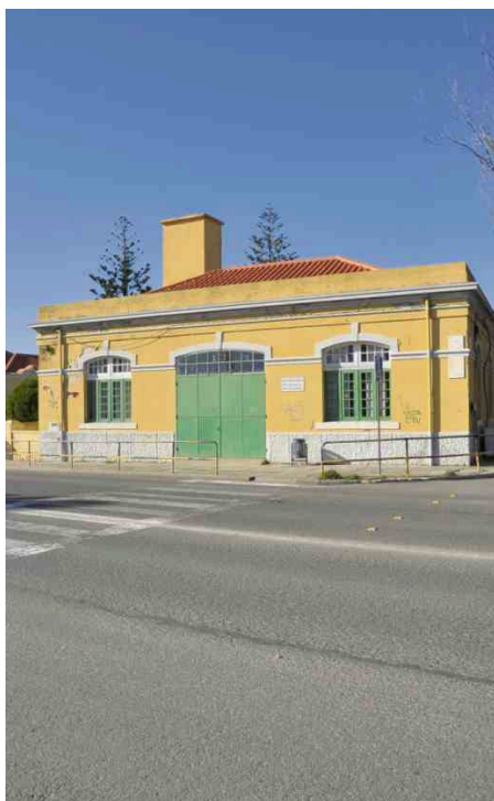
Instalações do projeto, na Av. General Humberto Delgado
