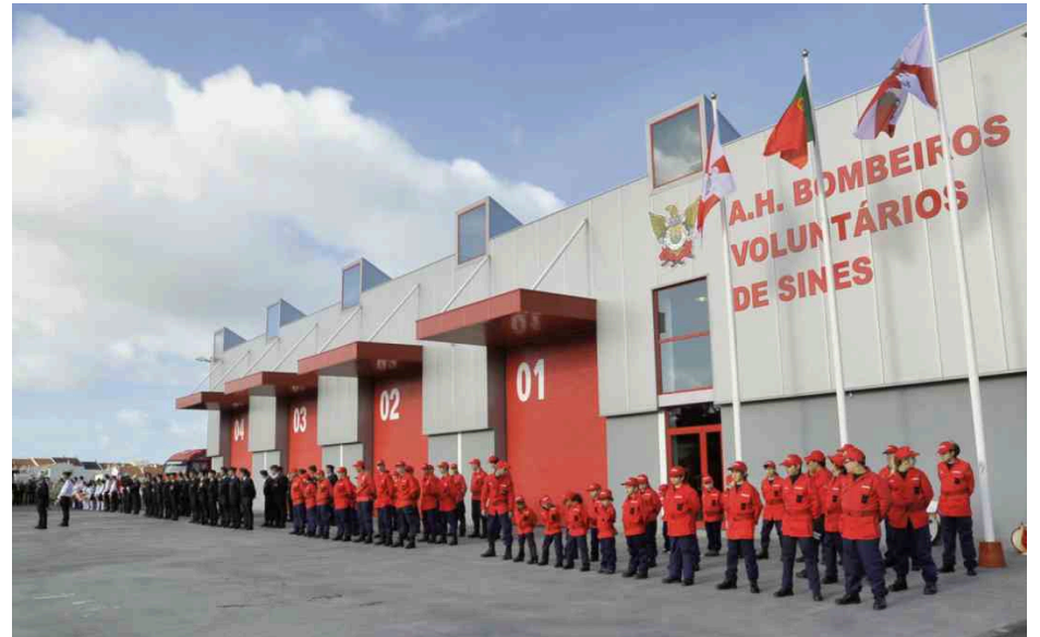
Edifício do novo quartel e corpo de bombeiros
