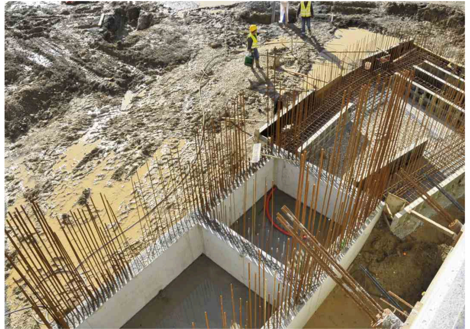
Fundações do elevador (Regeneração Urbana)
