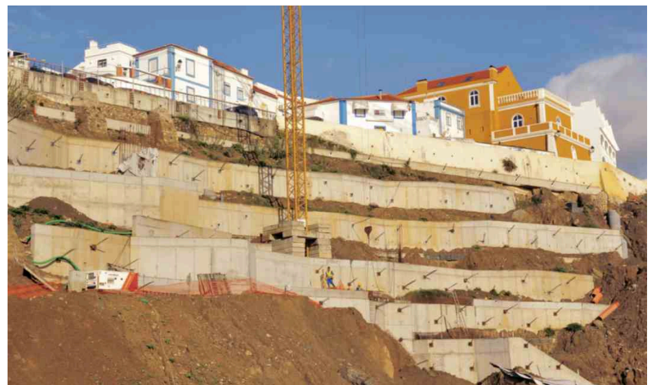
Programa de Regeneração Urbana de Sines - obras na falésia
