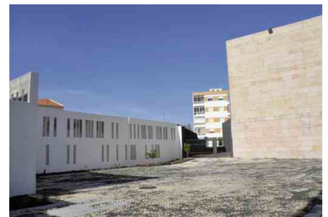
Pátio das Artes (Regeneração Urbana) - Concluído
