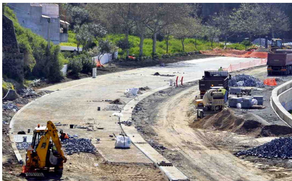
Obras de pavimentação da Avenida Vasco da Gama
