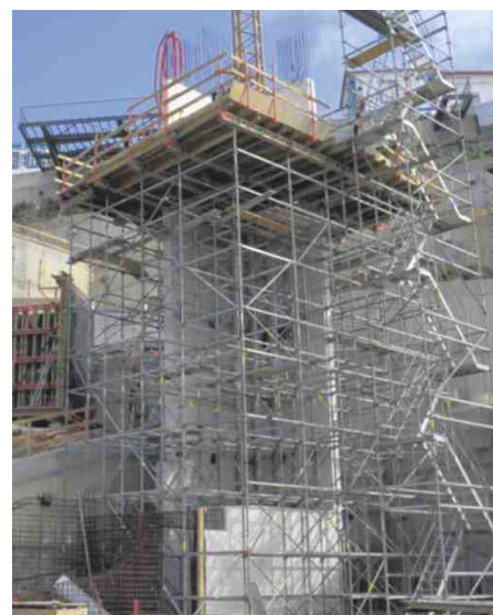
Construção do elevador
