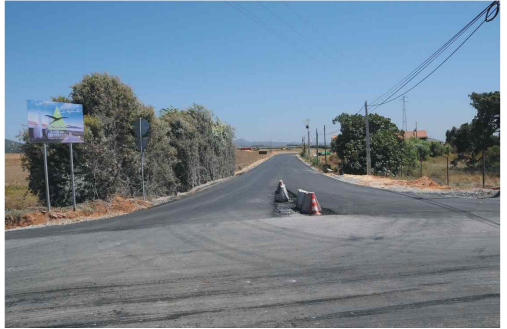
As obras no Caminho Municipal 1115 já tiveram início
