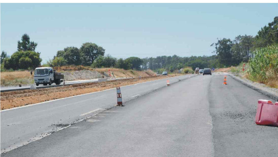
Obras em execução no IP8
