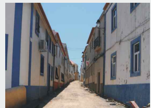
Arruamento do Centro Histórico em obras
