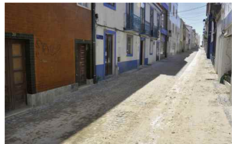
Requalificação dos arruamentos do Centro Histórico
