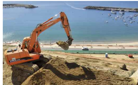
Obra na falésia
