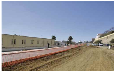
Obra na Av. Vasco da Gama
