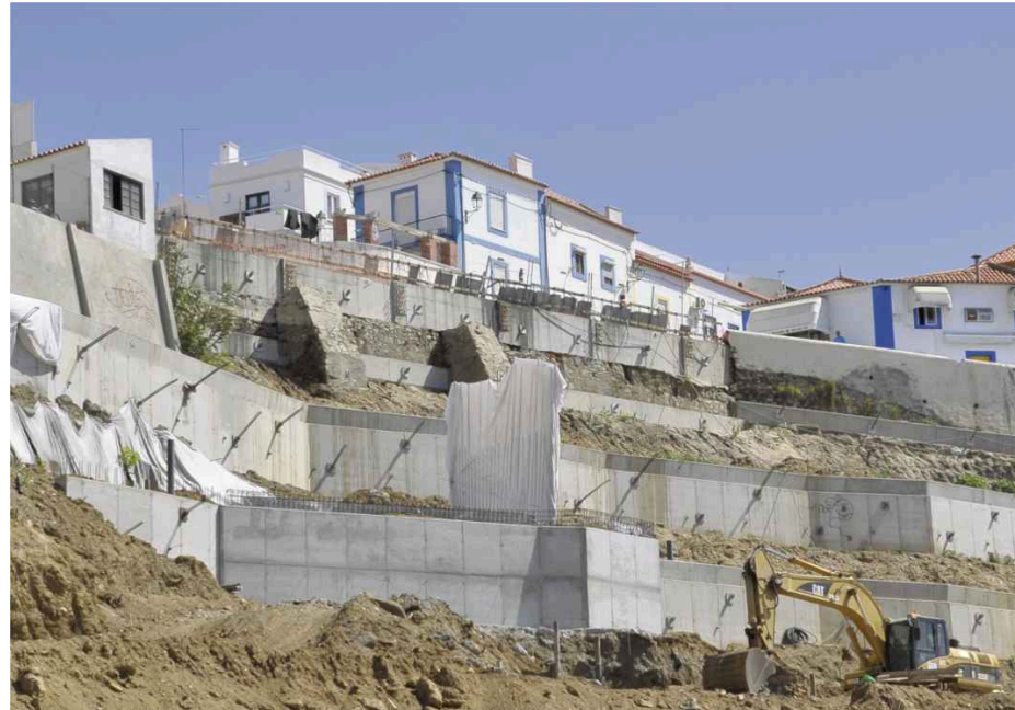
Consolidação da falésia
