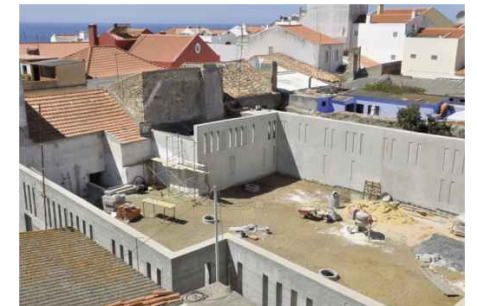
Obra do Pátio das Artes
