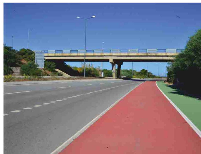
Viaduto da Rua da Floresta
