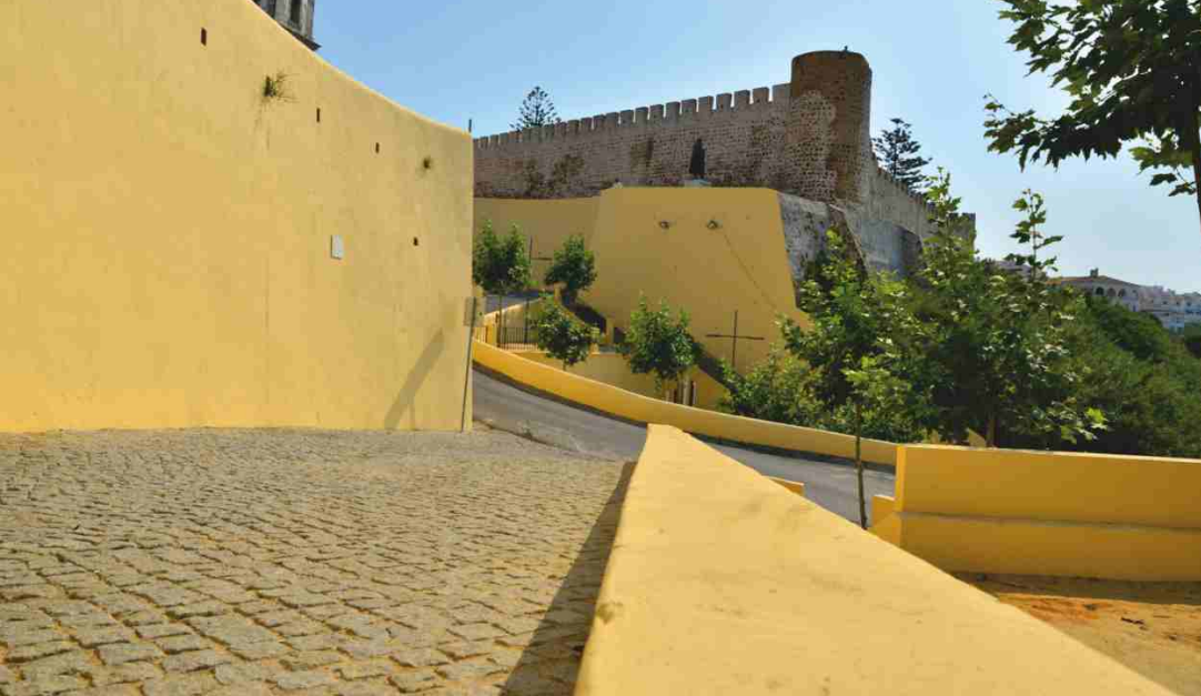
Os muros da praia são um ícone da cidade de Sines
