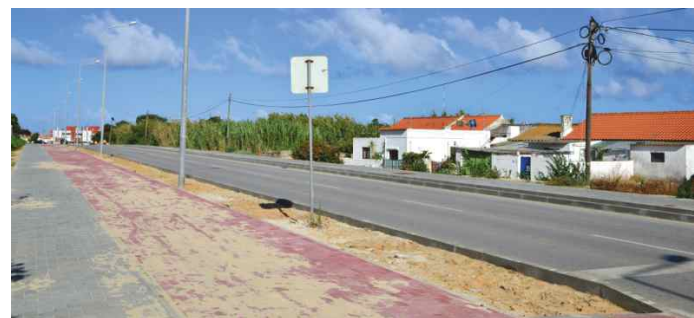
OBRA JUNTO À ESCOLA VASCO DA GAMA
