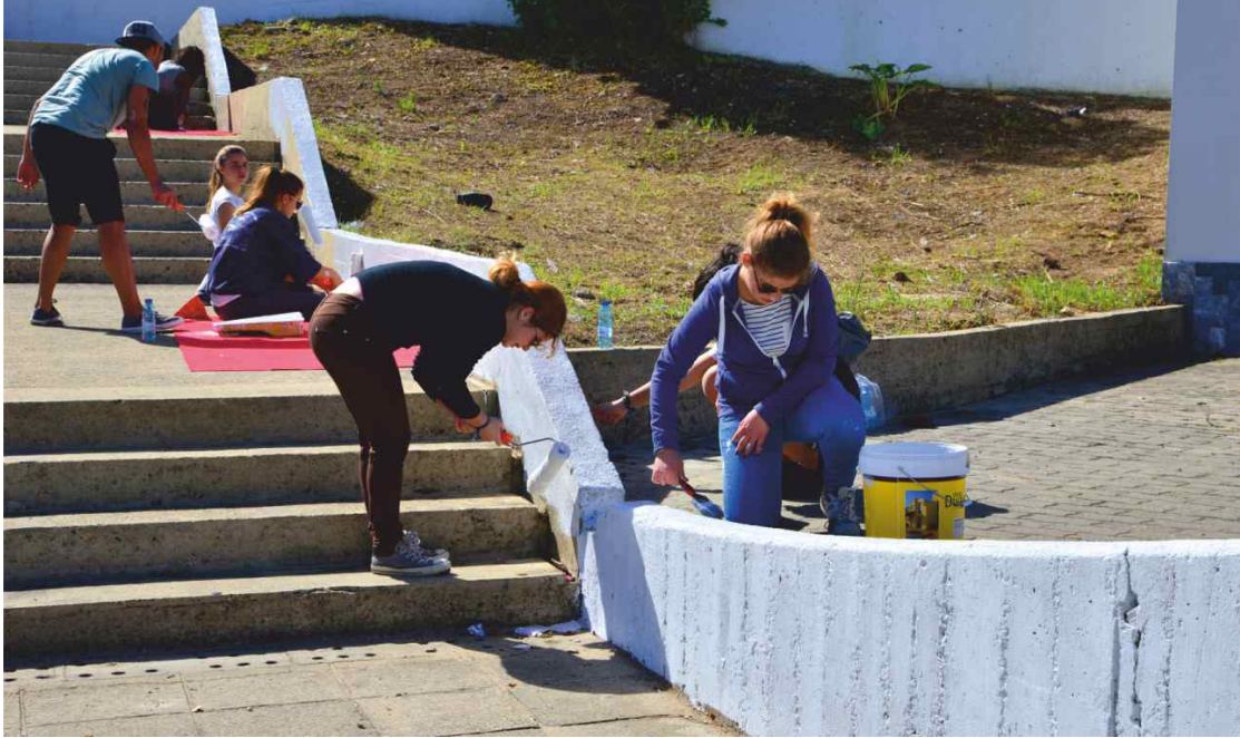
Reabilitação de muro junto à Quinta dos Passarinhos
