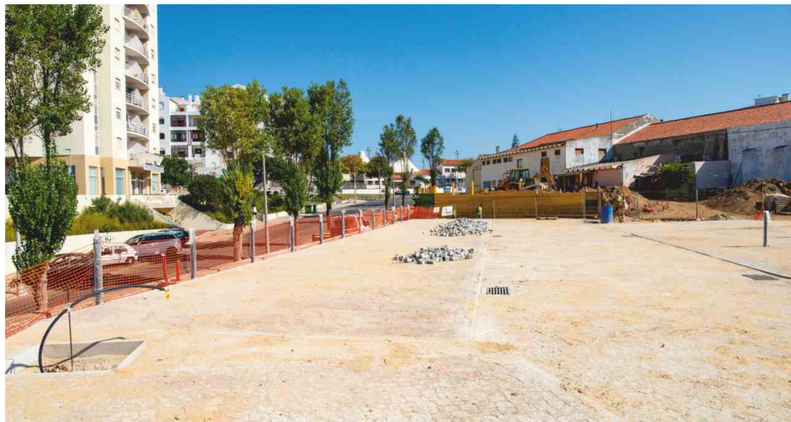
Estado a 21 de agosto da obra do estacionamento de apoio ao centro histórico e mercado municipal, junto à Friplex
