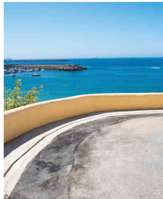
Valeta construída na estrada junto às Escadinhas da Praia
