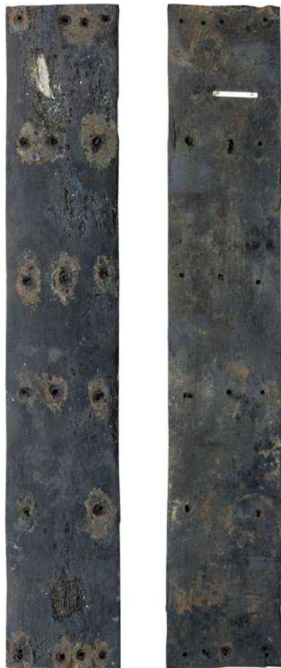
Tábua do forro exterior BV02_234
